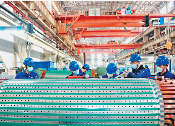
电机公司提供的国内首个30兆乏分布式调相机EPC项目，顺利通过 168小时试运行
